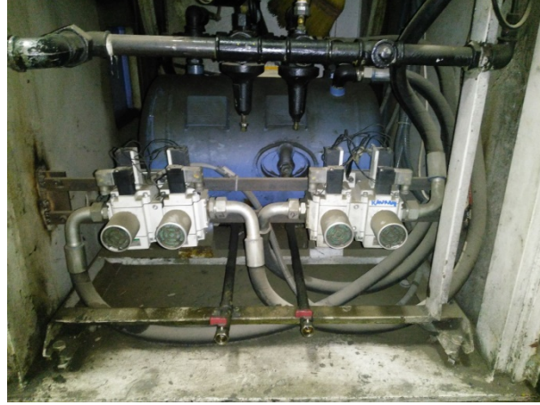
Resim 2. Hava deposu uygulaması
